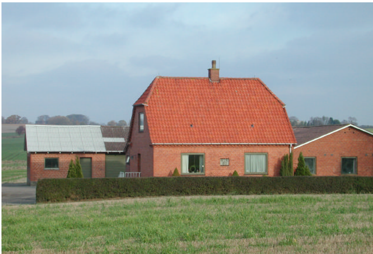
Det eksisterende stuehus på ejendommen, der eventuelt påregnes nedrevet senere efter fraflytning.
