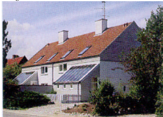
Solfanger som tag på lille sidebygning
